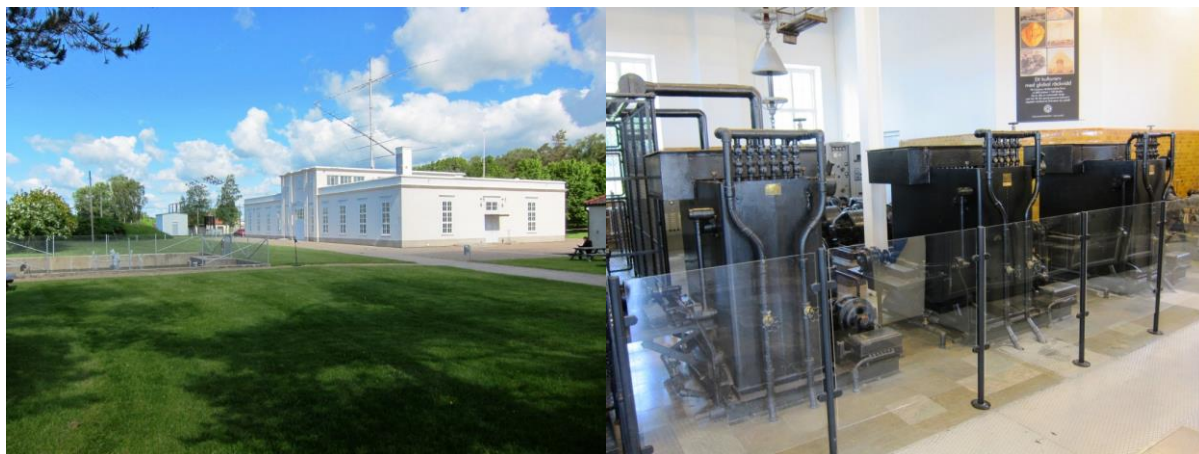
Stationsbygningen og kølebassin.
