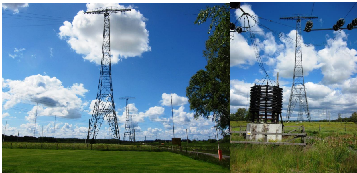
6 antenner, 127m høje og længde 2200m
